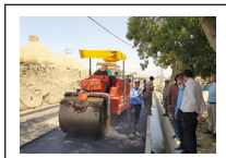
افزاعملیات آسفالت روستای سلمان آباد
